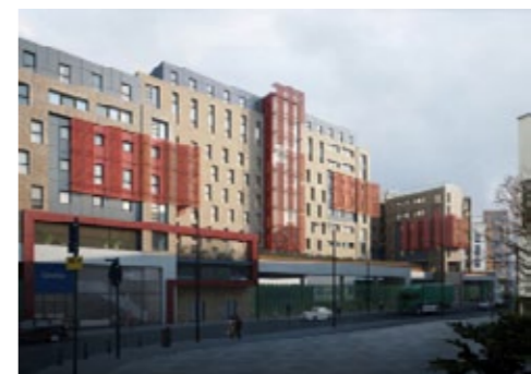
伦敦 Kings Cross 在建材商铺之上所建的 563 套学生公寓——施工中 563 Student Apartments on top of a builder's merchants, Kings Cross, London. Under Construction
